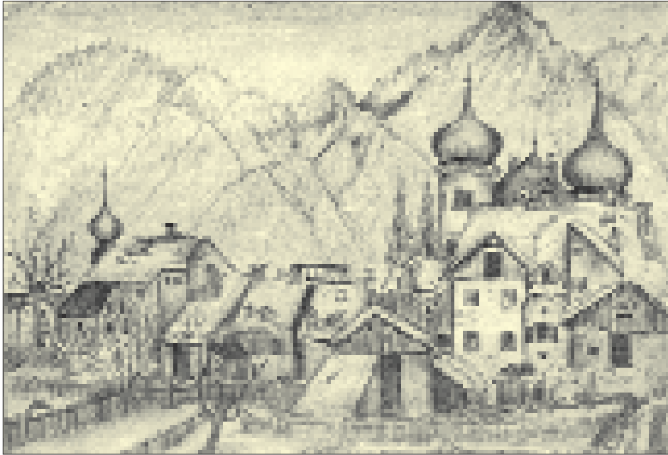
Abb. 6: Rückseite der nördlichen Häuserzeile des Lienzer Hauptplatzes. Der Turm des St. Antonius-Kirchleins überragt ein wenig das alte sogenannte Görzer-Haus, heute Pernusch, daneben ist die Rückseite des Wiesentheiner-Hauses (Hauptplatz Nr. 4) zu erkennen. Bleistiftzeichnung von Johann Hauer, 1879 (Privatbesitz). Foto: Meinrad Pizzinini
