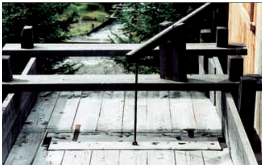
Die „Luke“ für das Rad der Kreissäge. – Der Verschluss wird durch den Hebel gehoben, das Wasser stürzt über die „Schoßbuisch“, den schrägen Fallschacht, auf das Rad und dreht es. ▼
