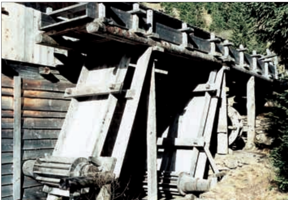
Die drei Wasserräder für den Antrieb der Kreissäge, der Gattersäge und der Kappsäge (von vorn nach hinten), darüber die wasserzuleitende „Wiere“.
