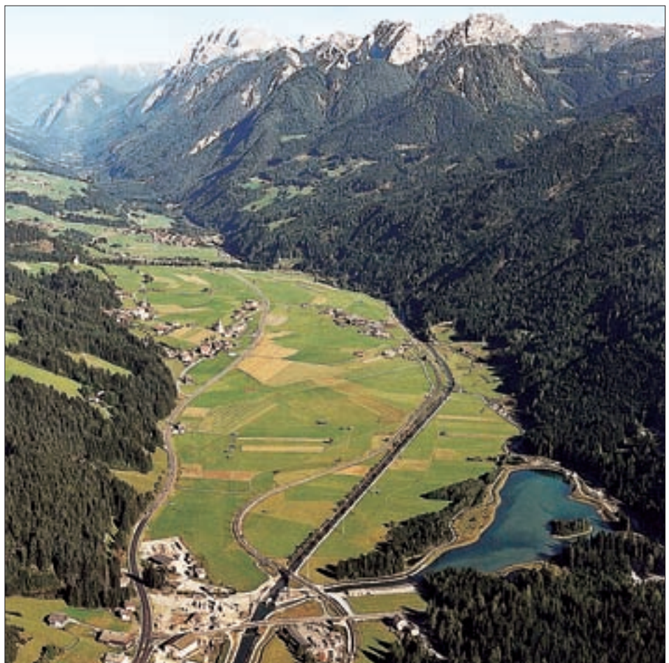
Der Tassenbacher Speicher am Südrand der Strassener Feldfluren mit Blick in Richtung Lienz. Foto: TIWAG
