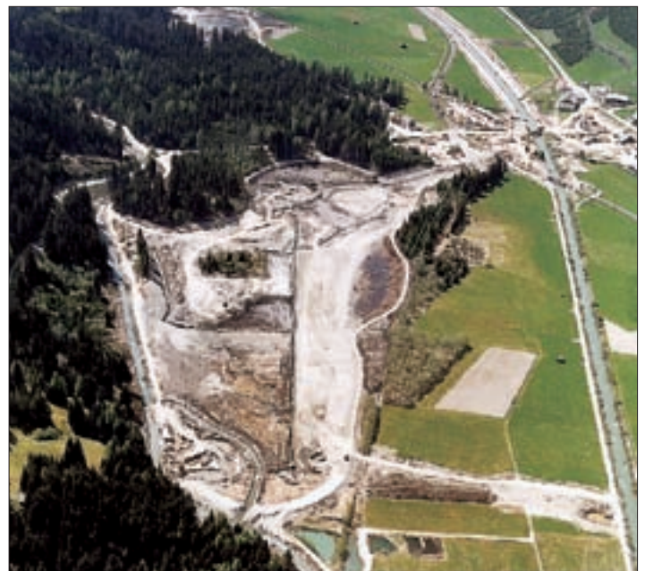
Tassenbacher Speicher, Bauphase 1984 bis 1988. Foto: TIWAG
