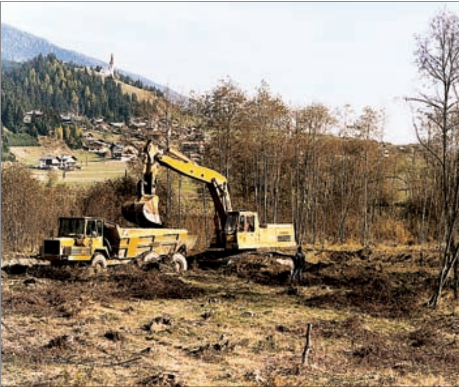
Abhebung des alten Oberbodens und Entnahme großer Pflanzenballen (Seggen, Hochstauden, Röhricht). Foto: TIWAG
