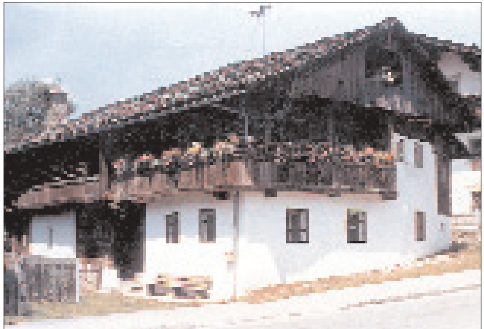
Das Taxeranwesen (links) mit angebautem Kramer-Haus in Patriasdorf; Aufnahme von Südosten.
