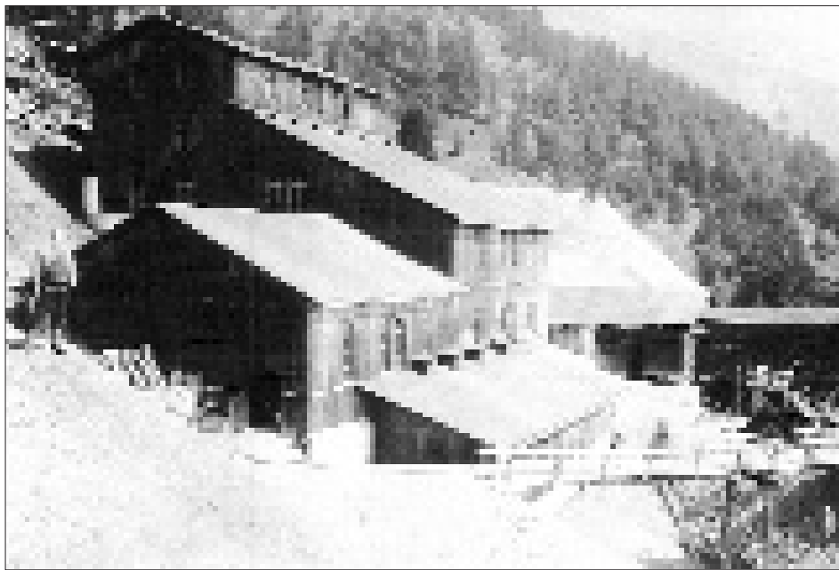
„Humboldt“-Erzaufbereitungsanlage des Bergbaues Tessenberg, 1917/18.
